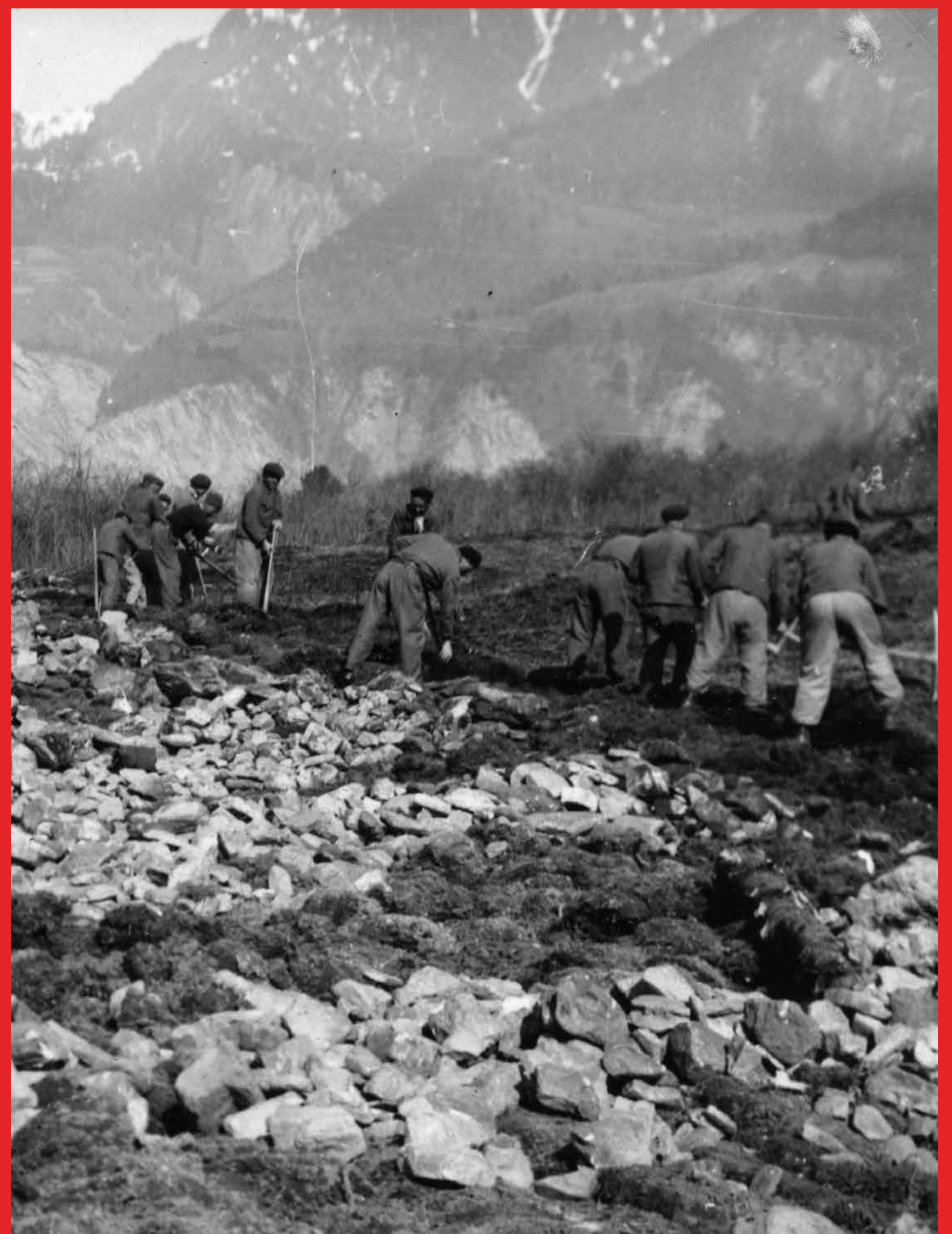
Neue Manduren: 500 m 3 Steine auf 7500 m 2 Boden – die Arbeit für die Stadt Chur konnte nicht abgeschlossen werden.
