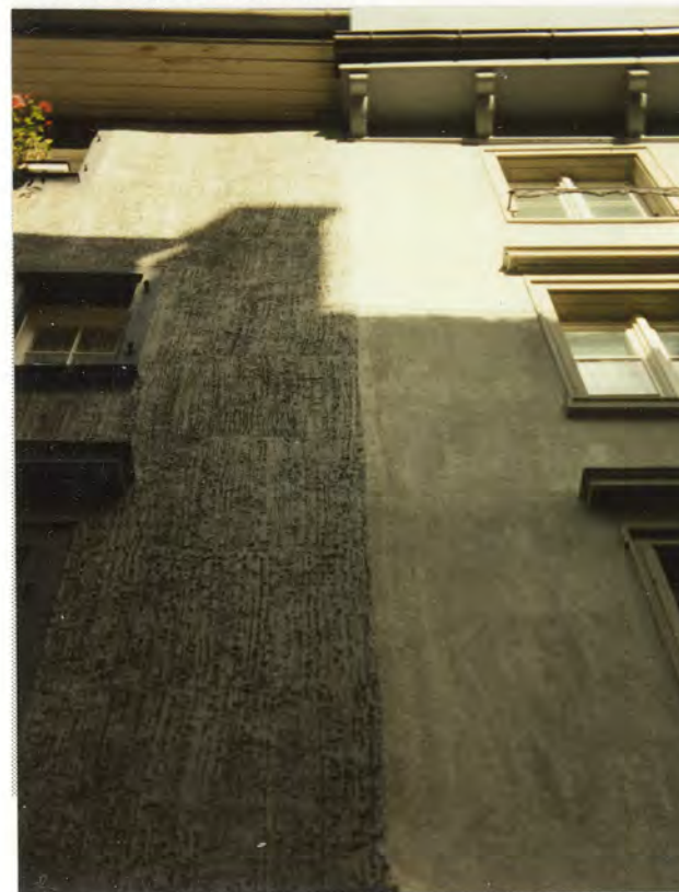
Putzwechsel zwischen zwei Fassaden
