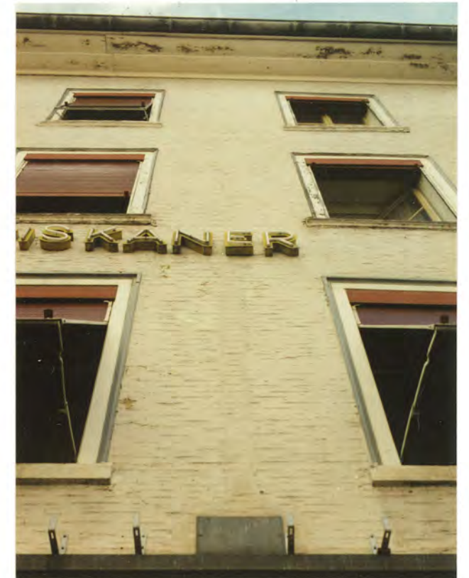
Hotel Franziskaner; künstliche, horizontal verlaufende Putzstruktur
