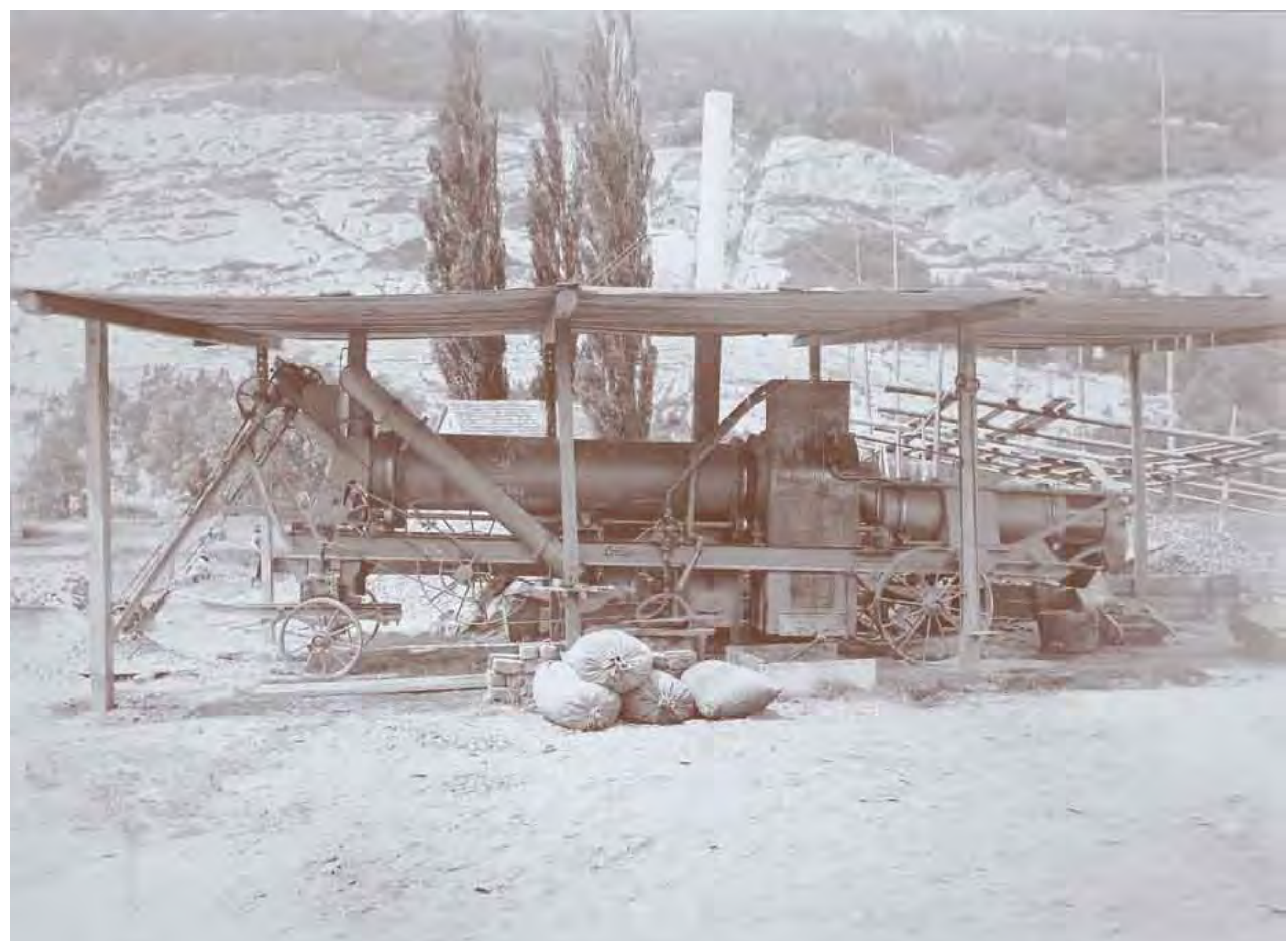
^ Diese Teerkies-Präparationsmaschine war in den 1910er Jahren auf dem Gelände des Gaswerks Rheinstrasse aufgestellt und verarbeitete den im Gaswerk anfallenden Teer.
