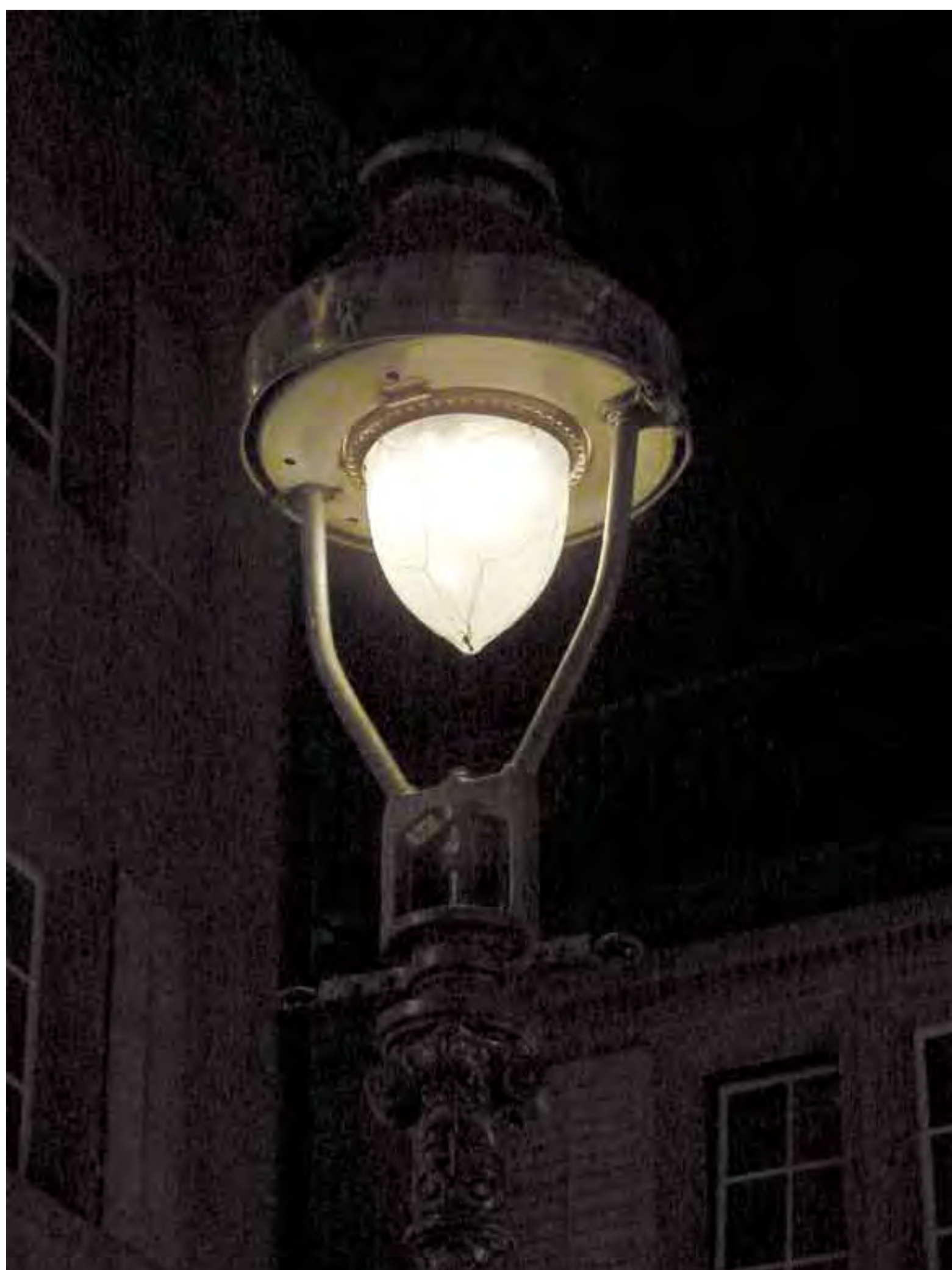
< Die Gaslaterne Nr. 36 vor der Regulakirche (vgl. Plan auf Tafel 1) ist heute die älteste der mit Gas betriebenen Strassenlaternen in Chur. Sie funktionierte jahrzehntelang elektrisch und wurde vor zwanzig Jahren wieder auf Gas umgerüstet.
