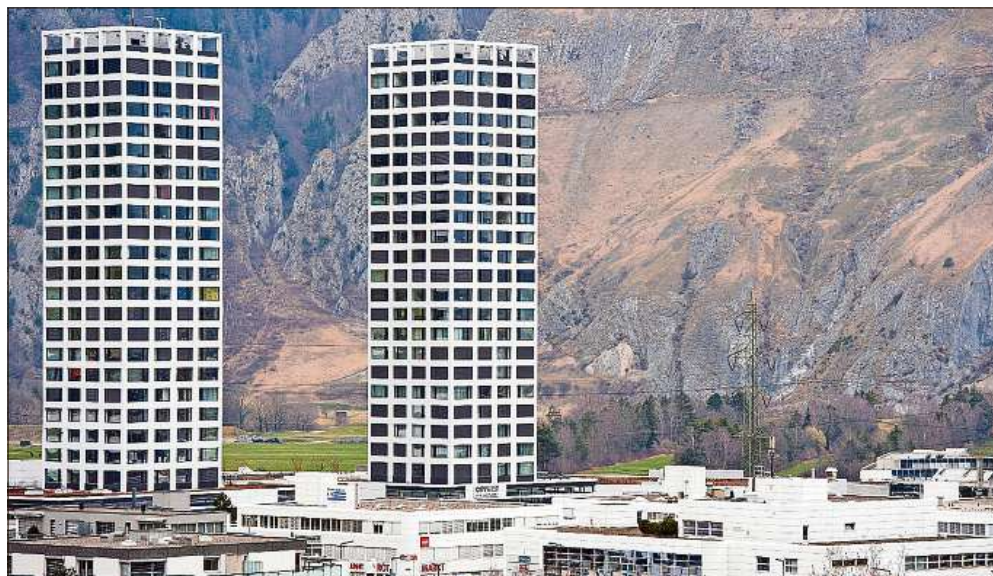
Ein Grundstückskauf und -verkauf macht es möglich, dass in Chur West neben den beiden City-West-Türmen ein drittes Hochhaus mit Wohnungen entstehen kann.
