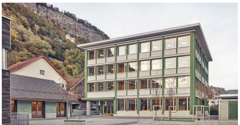
Neubau Schule und Kindertagesstätte Haldenstein (Lucas Murer)
