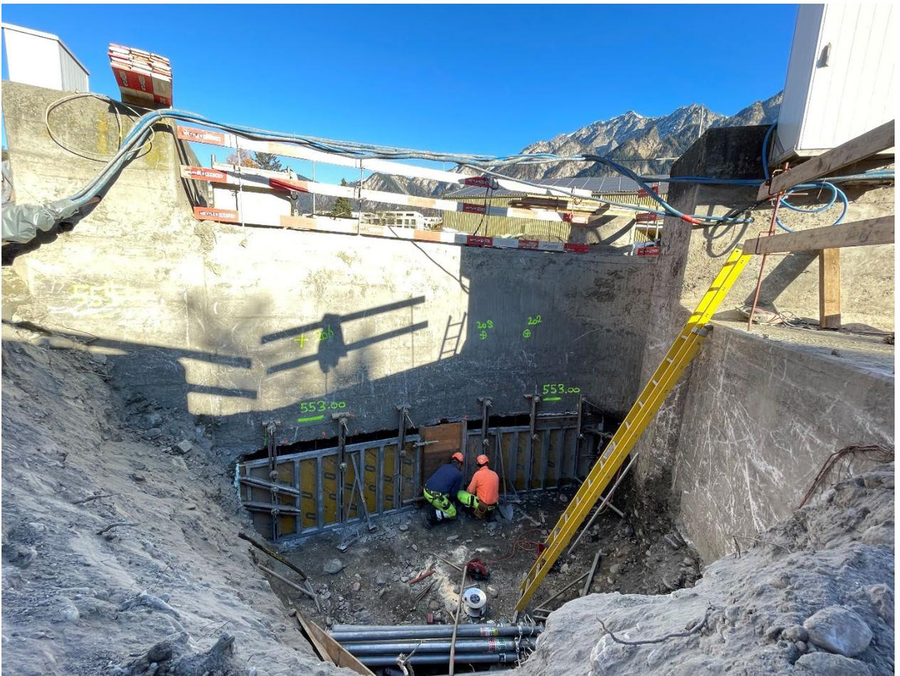
Unterfangen des bestehenden Zuflusskanals zum Regenüberlaufbecken
