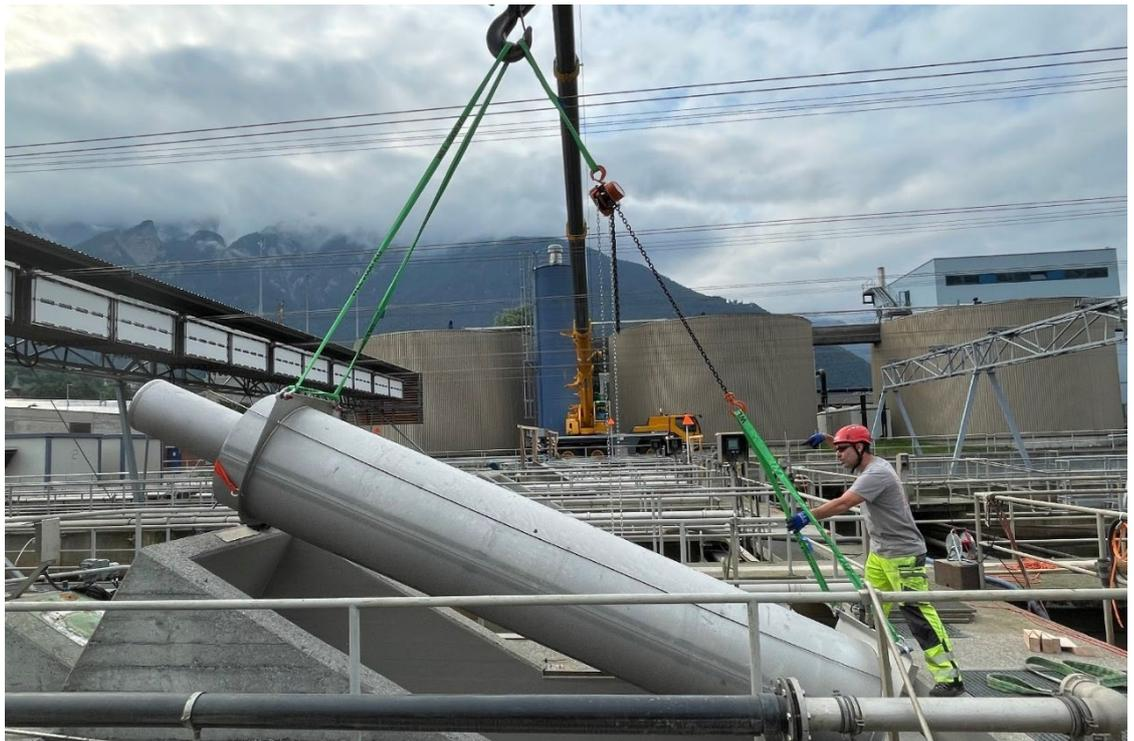
Einbau der neuen Rücklaufschlammumpen in sanierten Betontrög
