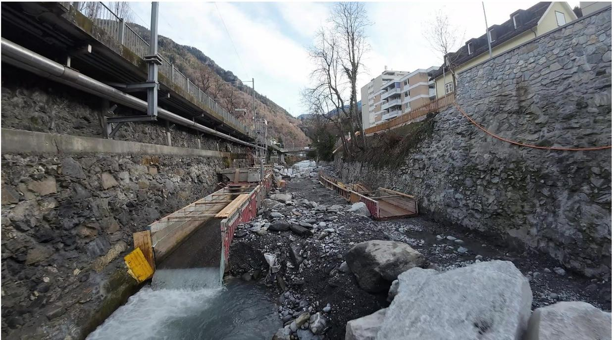
Wasserhaltung für Blockrampenbau bei km 2.809
