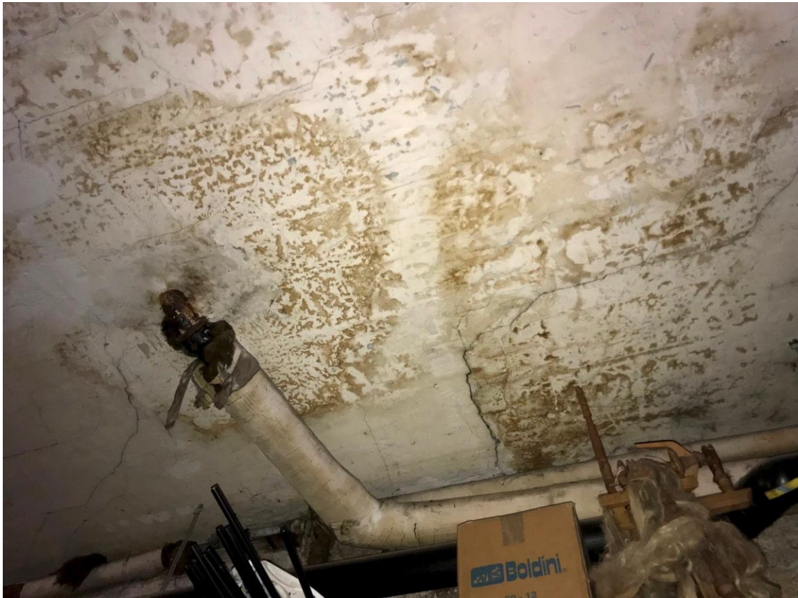
Abb. 22: Wasserschaden 2 EG
