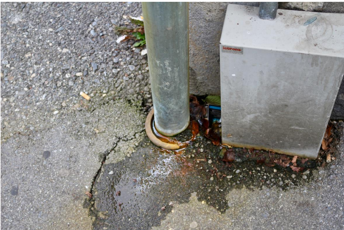
Abb. 10: Fallrohr verstopft
