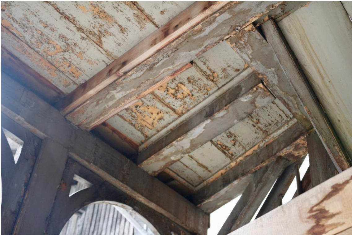
Abb. 29: Abblätterungen Erschliessung
