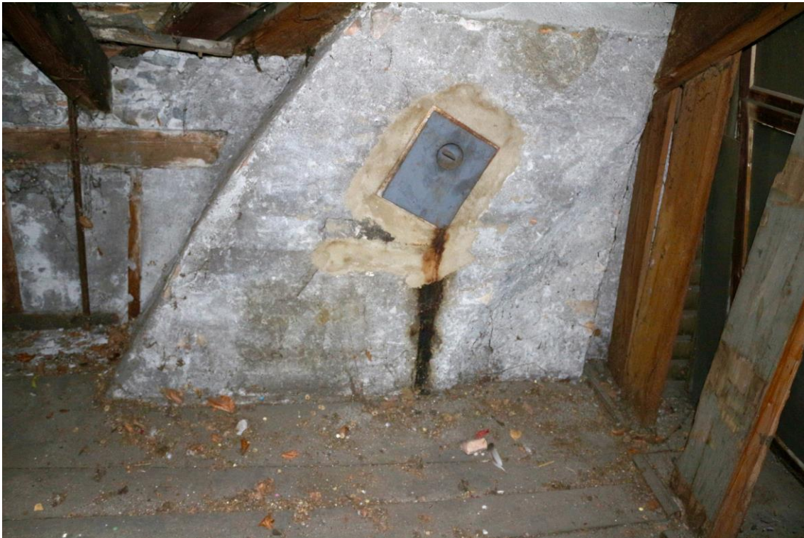
Abb. 16: Reinigungsöffnung
