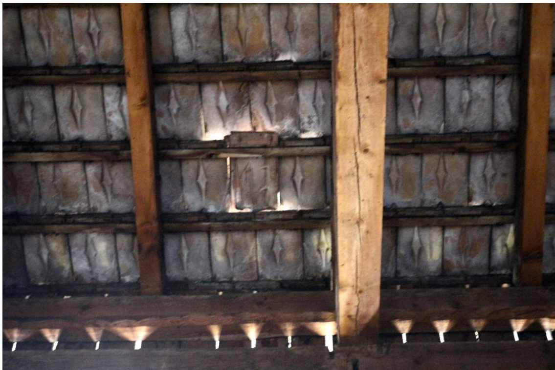
Abb. 5: Verschobene Ziegel
