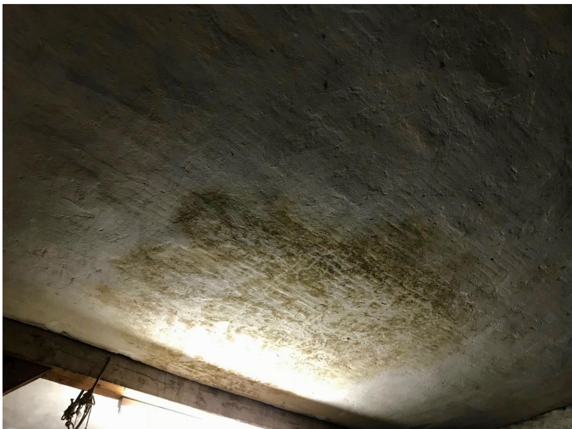
Abb. 23: Wasserschaden 3 EG
