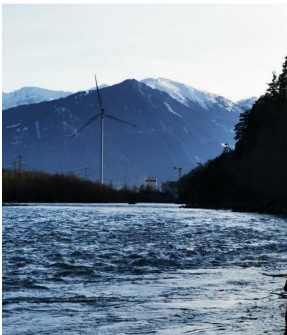
Abbildung 22: Blick vom linken Rheinufer am Fusse des Äberchopfs (in Flussrichtung) in Richtung Süden mit WEA Oldis I am linken Rheinufer neben dem Kieswerk Oldis. (Foto: ARNAL AG, dat. 24.02.21)
