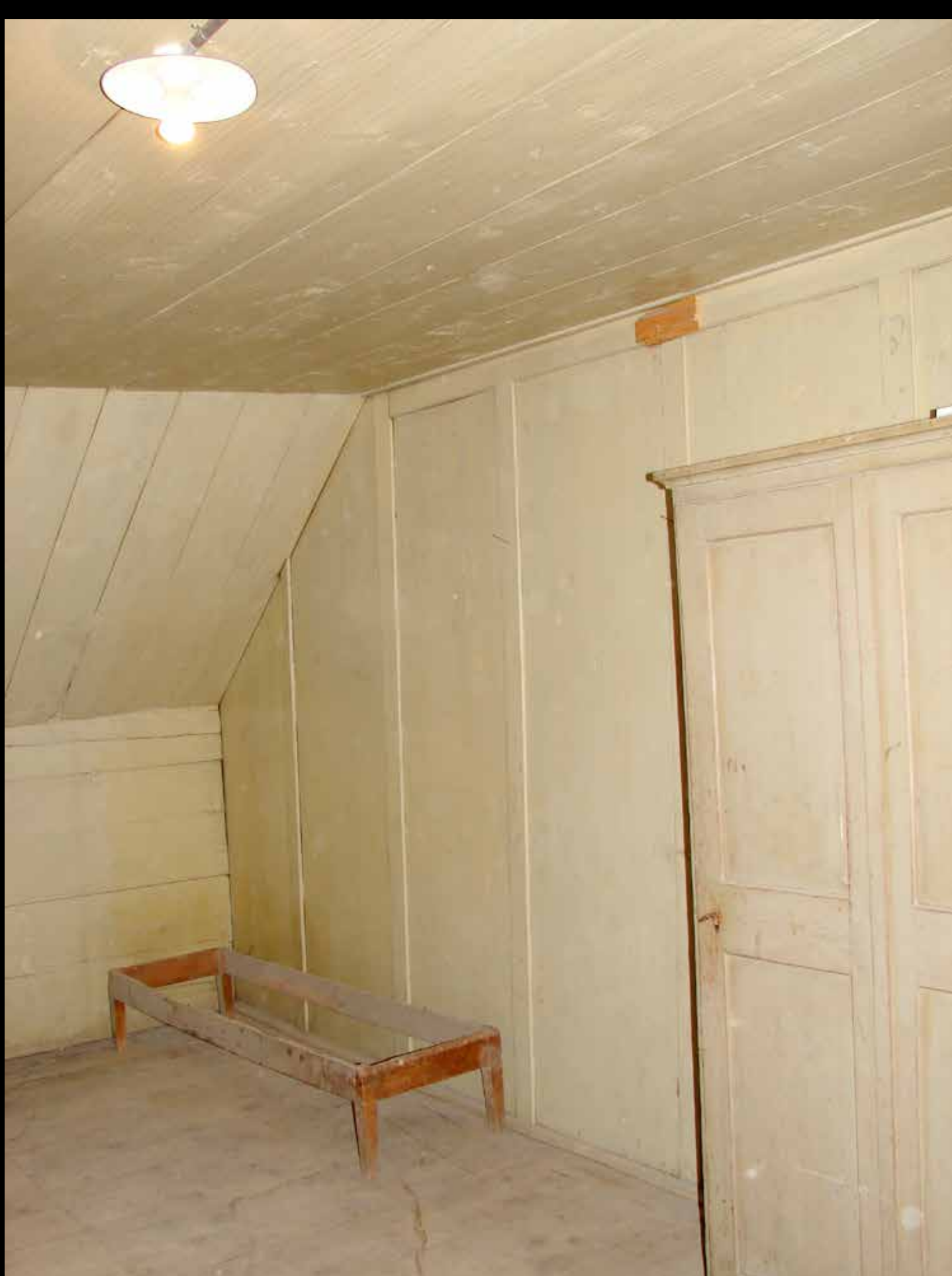
Zelle Nr. 2, Blick nach Nordwesten. Der graugrüne Anstrich stammt aus den 1880er-Jahren.
