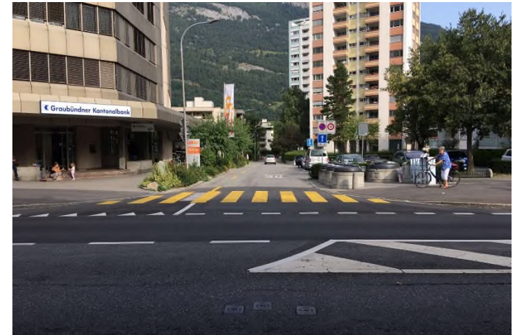
Fehlendes Eingangstor Kurfirtenstrasse
