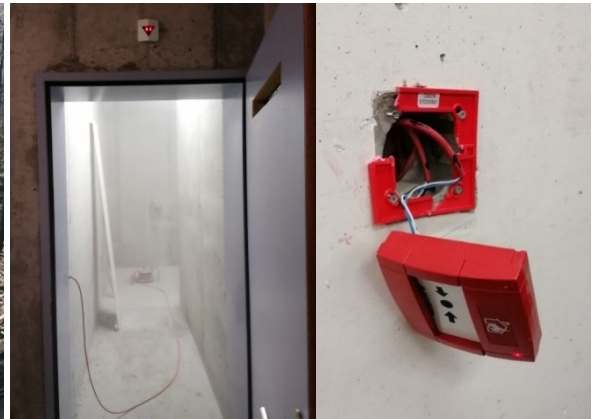
Auslösegründe für Brandmeldeanlagen: Staubentwicklung bei Bauarbeiten / Mechanische Gewalteinwirkung auf Handtaster
