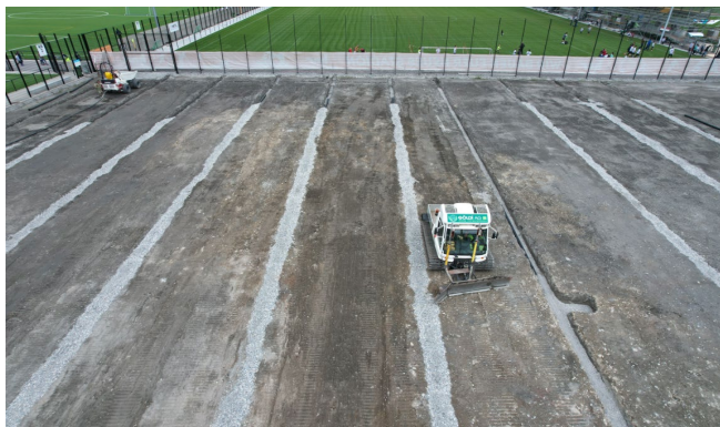
Bau Naturrasenplatz Nr.2
