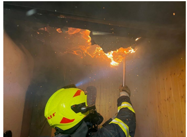
Brandeinsatz in einem Einfamilienhaus: die Flammen hatten sich in Decken und Zwischenwänden ausgebreitet und mussten durch Öffnen der Verkleidung bekämpft werden
