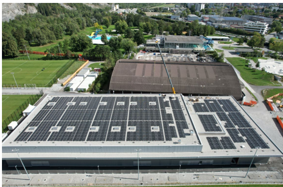
Trainingseishalle mit PV Anlage
