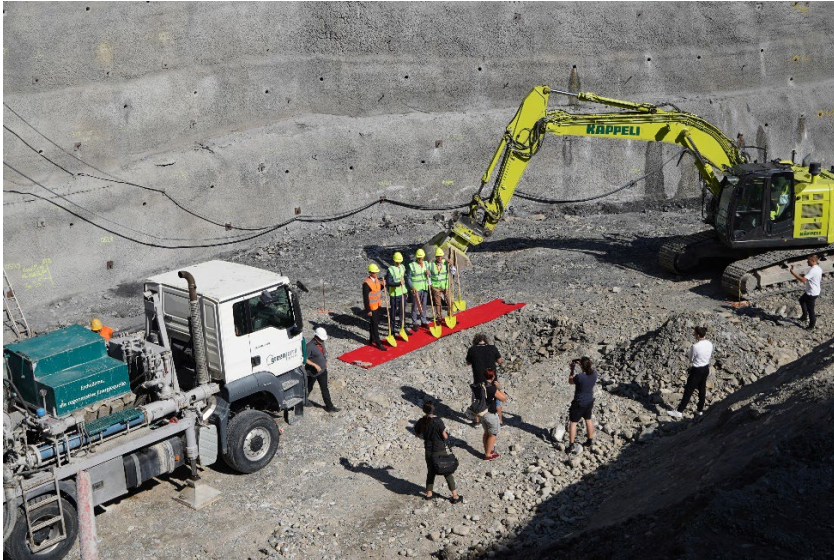
Der feierliche Spatenstich beim Bauprojekt «Mehrwerk» am 16. August. Dies wird der Standort des neuen Stadtarchivs (Foto Stadt Chur)
