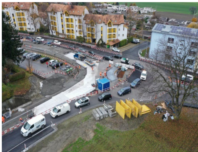
Baustelle Kreisel Masanser-/Scalärastrasse
